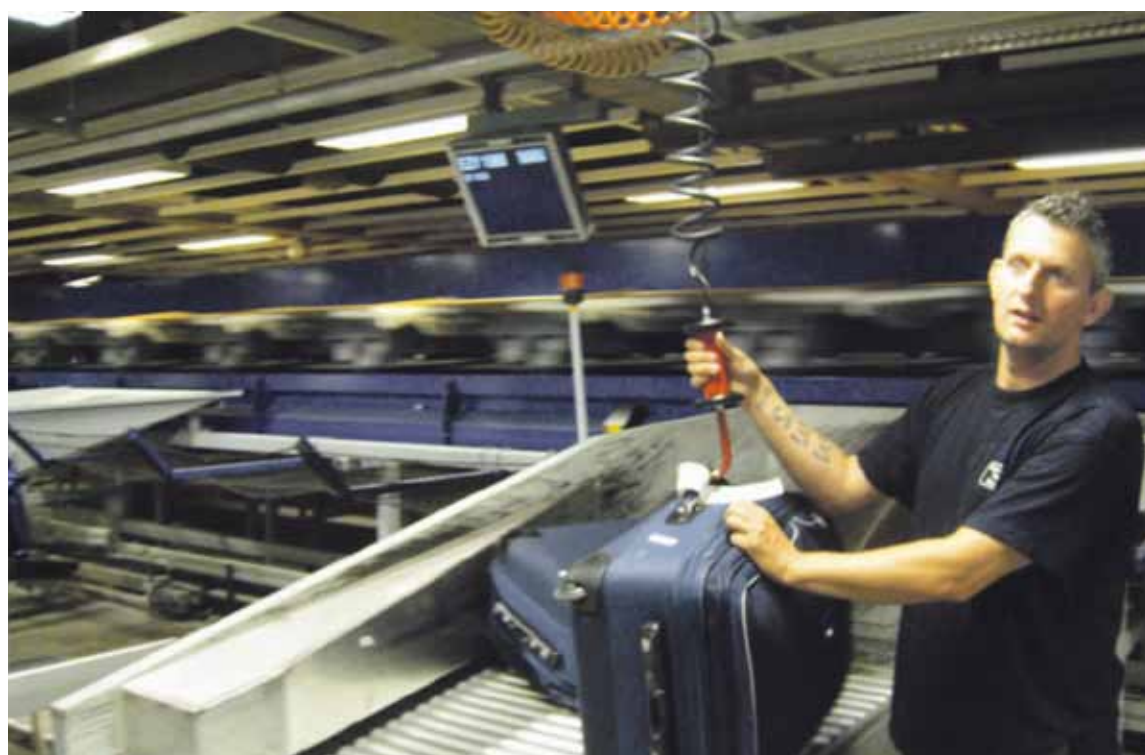
David Sørensen bruger hydraulisk krog i bagagehallen, selvom den kan give ryk.
